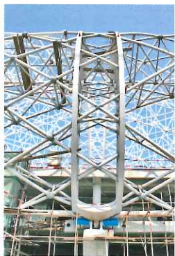
Bauzustand der Zwillingsträger
